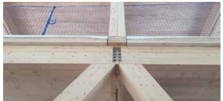
Fotografia 2. Detall de l'edifici d'oficines T3 Diagonal Mar, situat a Barcelona. Es tracta de la primera estructura d'oficines construïda íntegrament amb fusta a Europa (Autor: Incafust).
